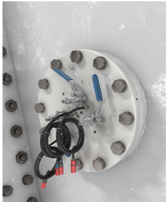
Abb. 18 Versorgungsflansch in der Druckwand eingebaut
